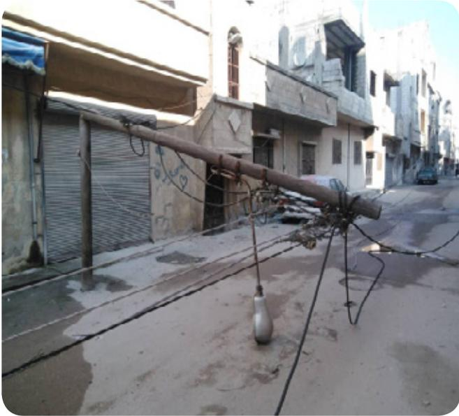
ذكر مدير شركة كهرباء حمص المهندس محمود حديد أن العاصفة الهوائية التي ضربت البلاد يوم الأربعاء الماضي 29 آذار أدت إلى أضرار في الشبكة وسقوط وانهيار بعض الأبراج والأعمدة.. فالأضرار التي وقعت على الخط المزدوج مخارج 20 كيلو فوط "التوتر المتوسط" هي سقوط خمس أبراج و عامود واحد وتوزعت في مناطق عدة فهناك بـرجان في تفرعة عرجون، و برج على خط مهين و برج على خط القبو والبرج الخامس على خط بلقسة... في حين أن العمود الذي سقط كان في قرية نوى ..
